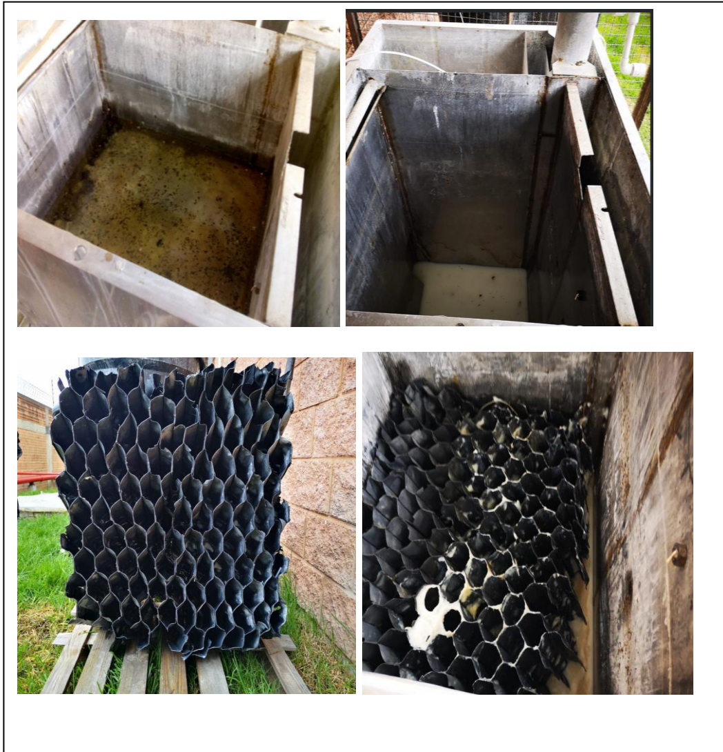
Fig. 15. Sedimentador estado actual 2019 Fuente Propia
