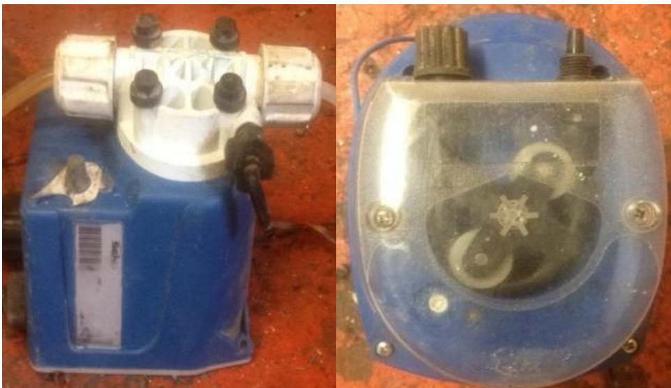
Fig. 22. Bombas Dosificadoras estado actual 2019, Fuente Propia
