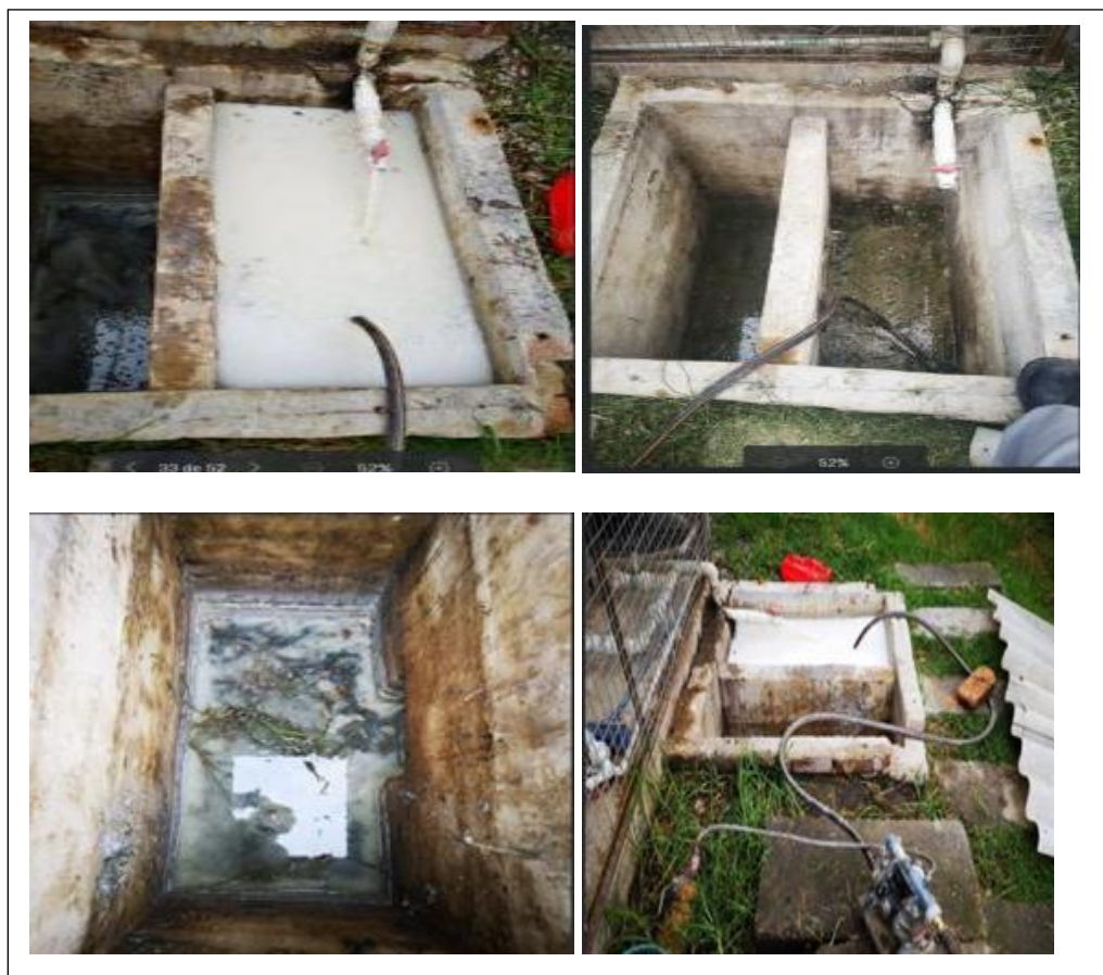
Fig. 23. Pozos de lodos estado actual, 2019 Fuente Propia
