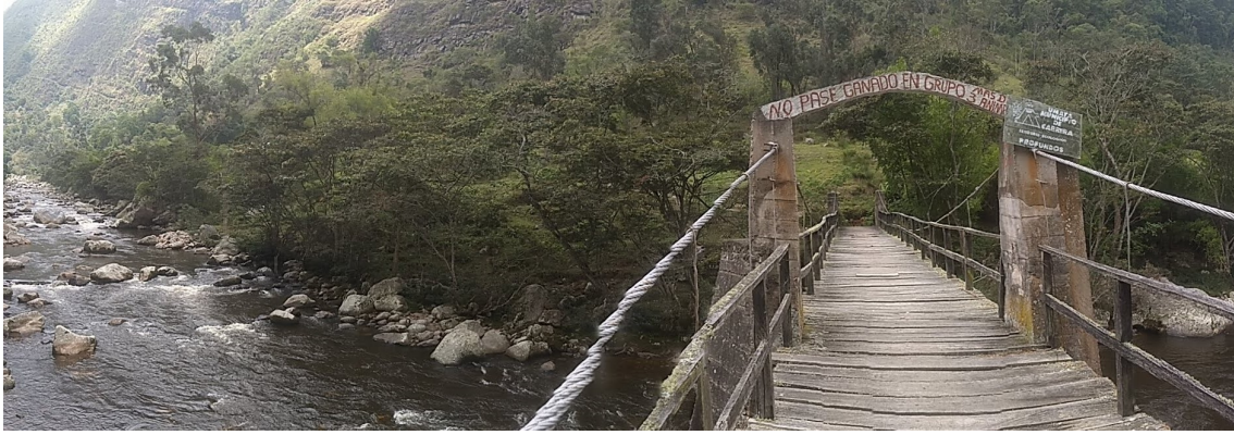
Ilustración 7, Puente profundos en Cabrera Fuente: Propia
