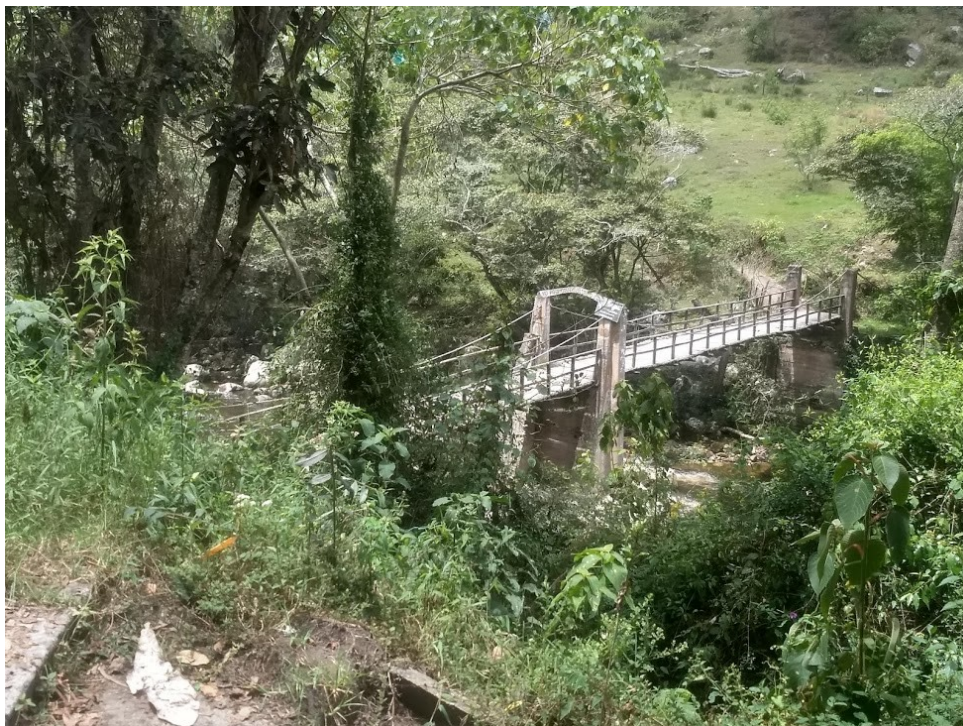
Ilustración 6, Puente profundos en Cabrera Fuente: Propia
