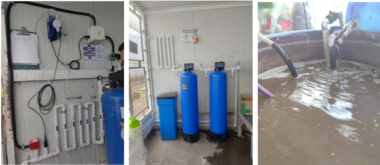
Figura 3. D, E y F) Sistema de tratamiento para agua de proceso en predio floricultor.
