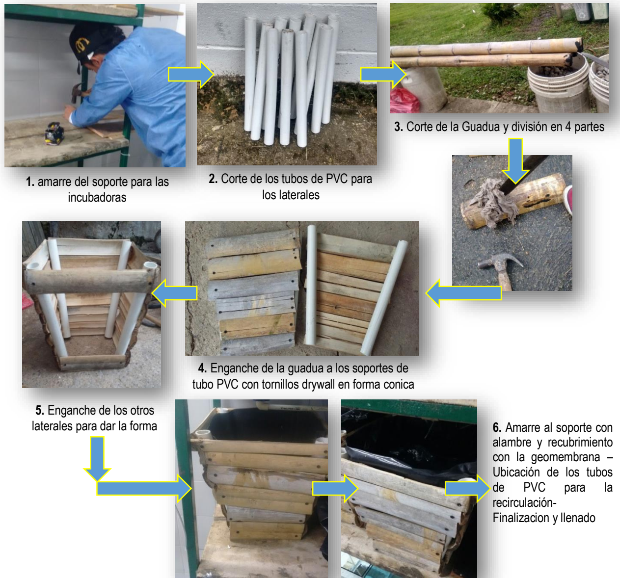
Figura 11. Elaboración del prototipo Guadua con geomembrana.
