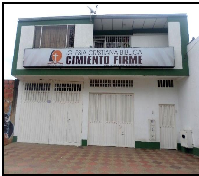
Imagen 44: Fachada de la Iglesia Cristiana Cimiento Firme.
