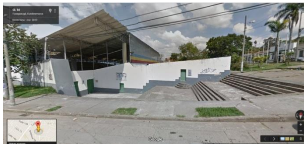
Ilustración 8 Ubicación por la aplicación Google Street View del Coliseo Carlos Lleras para el sector IDERF
