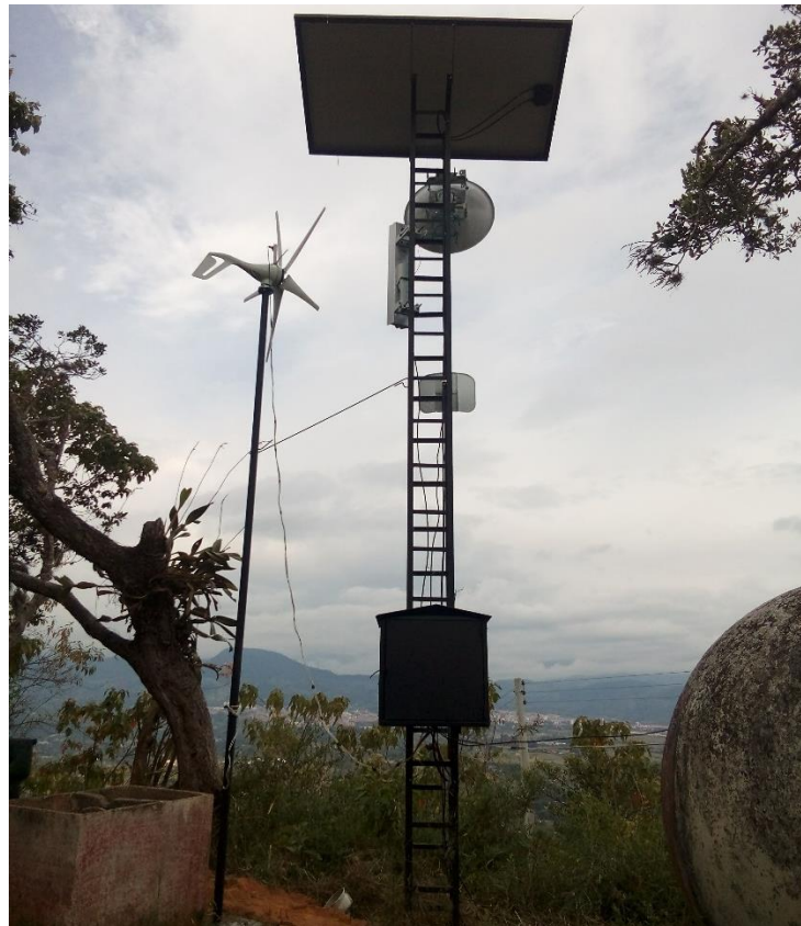
Figura 46. Instalación estructura de soporte del sistema eólico Fuente: Autor
