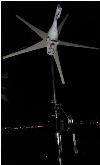
(a). Primera instalación de la turbina en San José del Chocho
