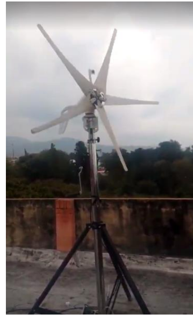
(c). Segunda instalación de la turbina en San José del Chocho
