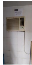
Imagen 9. Cambio Aire acondicionado
