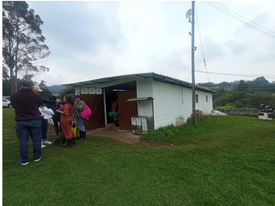
Figura 18. Inspección techo. Fuente: Propia.
