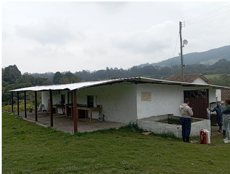
Figura 19. Inspección tanque. Fuente: Propia.
