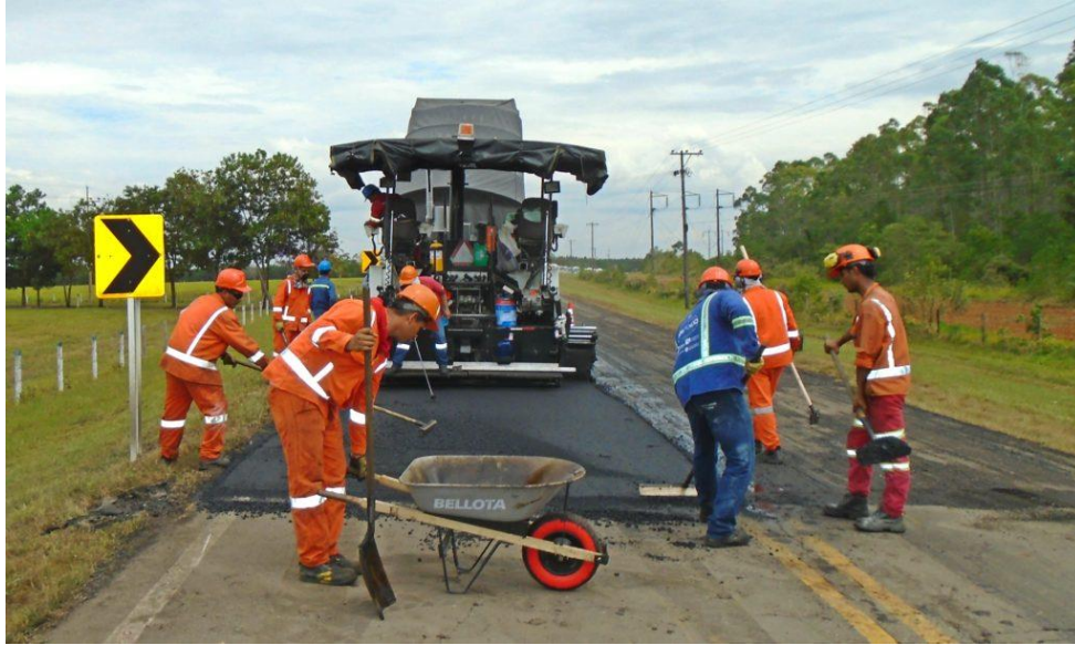
Imagen 12.construccion vial, vía del Meta
