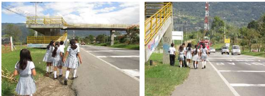
Fotografías 4 puente Peatonal Dela vereda Bosachoque
