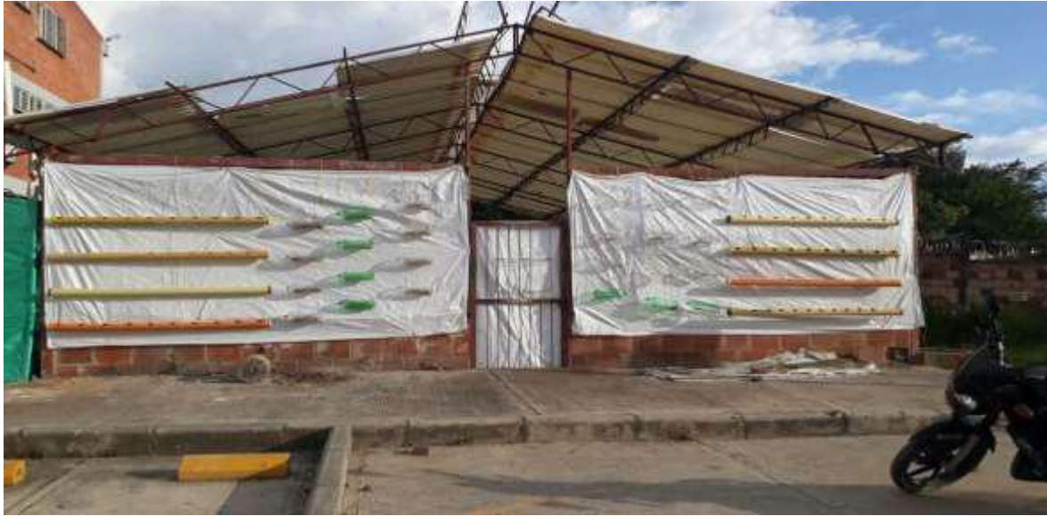
Imagen 3 Montaje sistema vertical casa malla UdeC
