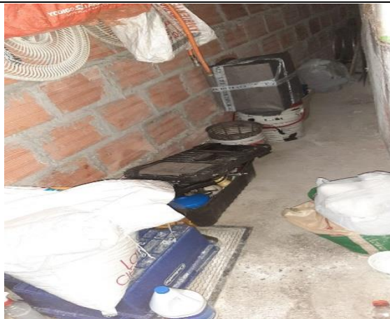
figura 13 Presencia de residuos inorgánicos amontonados, falta de higiene y rincones oscuros, todo esto estaba junto a la cocina donde se preparan alimentos.
