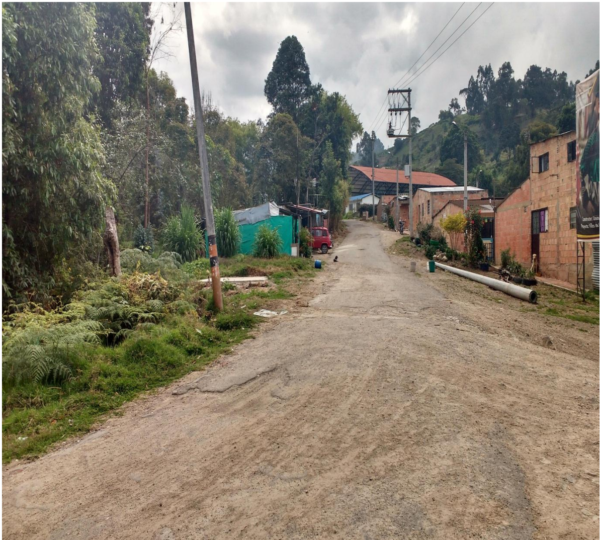
Foto 1: Casas en zona de alto riesgo.
