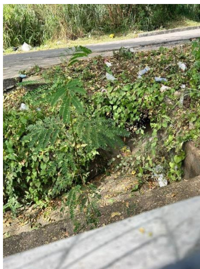
Imagen 13. Inundación por modificación de escorrentía central de la Institución
