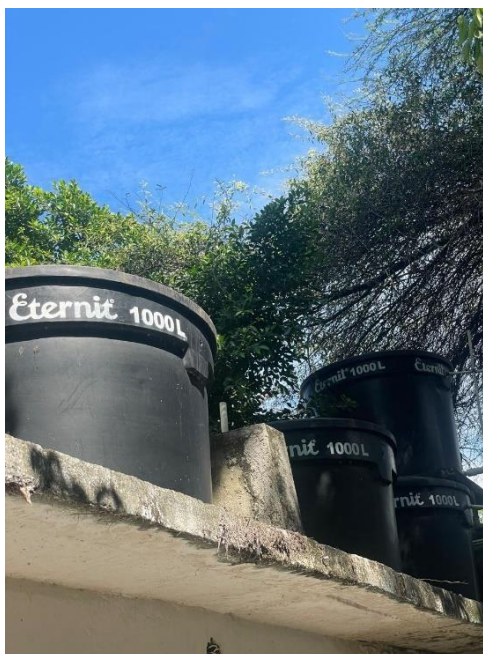
Imagen 5. Tanques de almacenamiento de agua en buen estado
