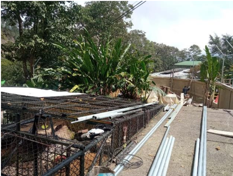
Ilustración 25 Vista superior de la construcción del nuevo recinto
