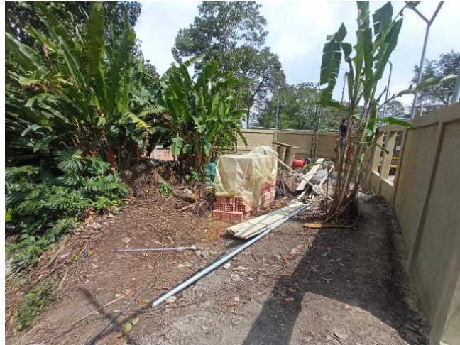
Ilustración 27 Vista interna de la construcción del nuevo recinto
