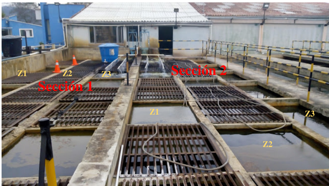
Figura 6. Secciones y zonas paralelas de los floculadores
