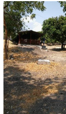
Sistemas de tratamiento
