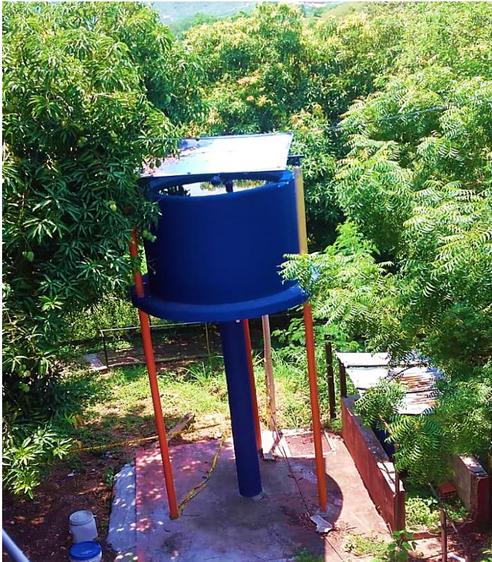
Figura 3. Tanque cilíndrico - Laboratorio de aguas
