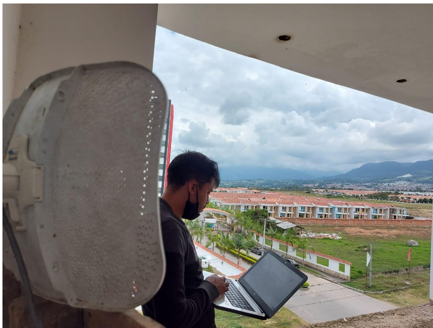
Figura 14: Pruebas para asegurar conectividad con la antena access-point
