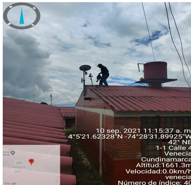
Figura 12: Inspección Antena Nodo Venecia
