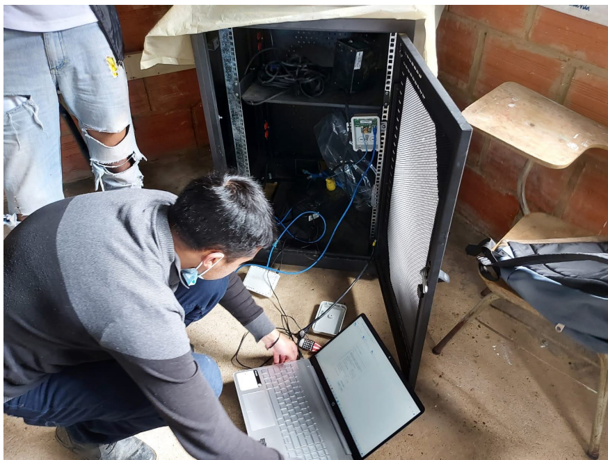
Figura 10: Revisión general de la instalación
