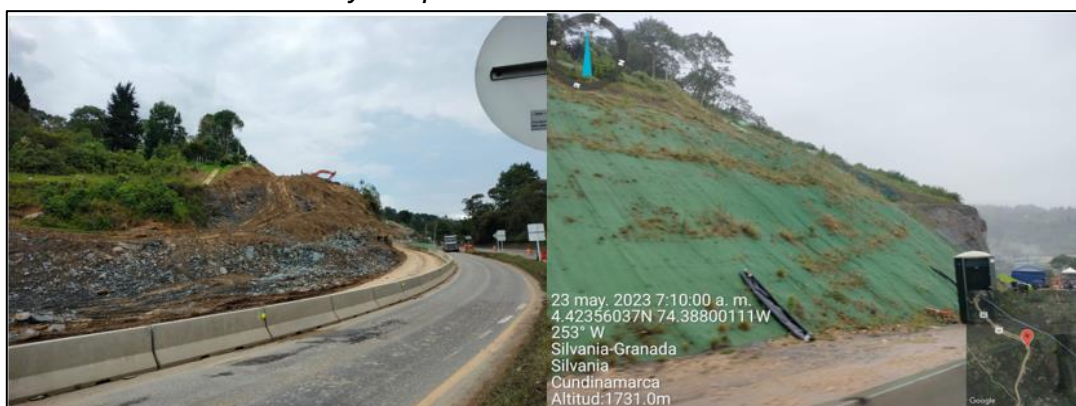
Ilustración 40. Antes y Después Frente de obra en la unidad Funcional 5.
