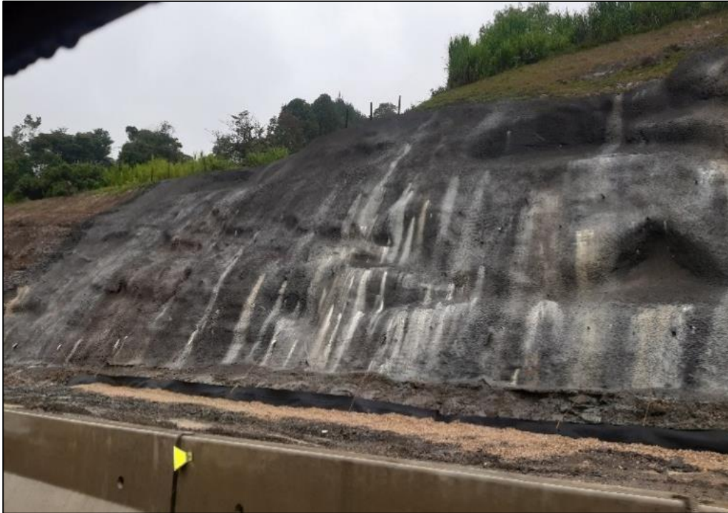
Ilustración 8. Muro de contención
