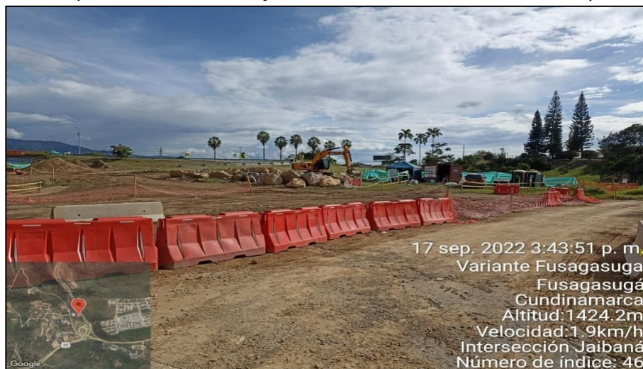
Ilustración 2. Ampliación tercer carril y mantenimiento de la intersección puente Jaibana
