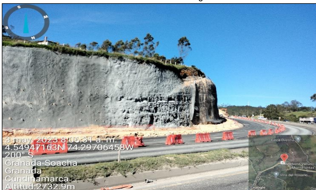
Ilustración 20. Identificación Progreso Obra
