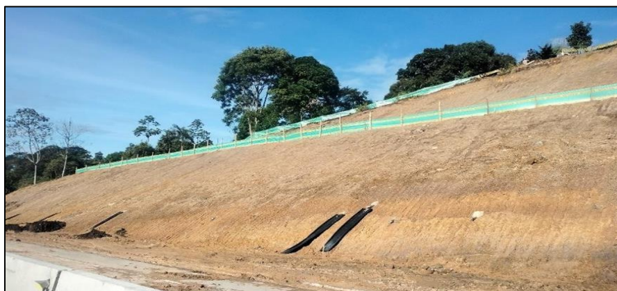
Ilustración 11. Obra: construcción de talud, siguiente paso elaboración de zanjas de coronación
