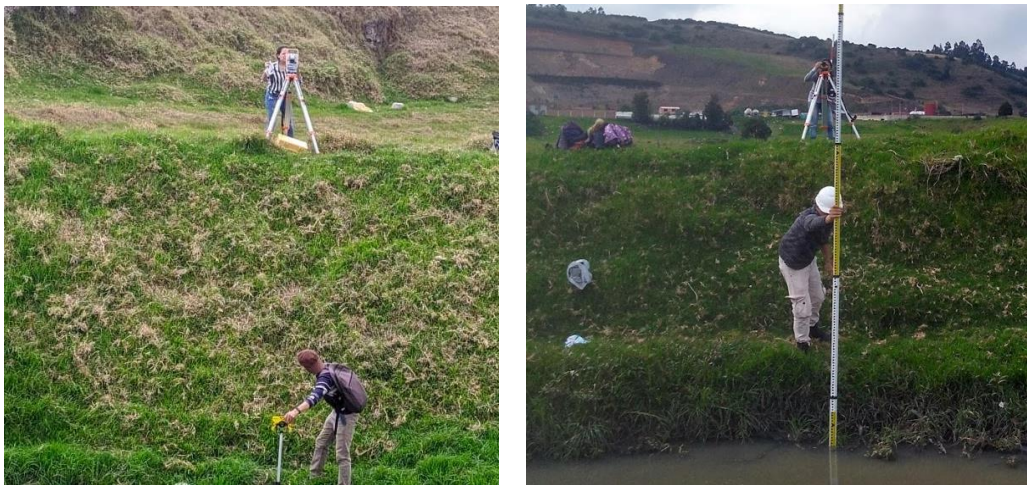
Figura 13. Batimetría elaborada con estación total (izquierda), y con nivel topográfico (derecha). Fuente: Autores
