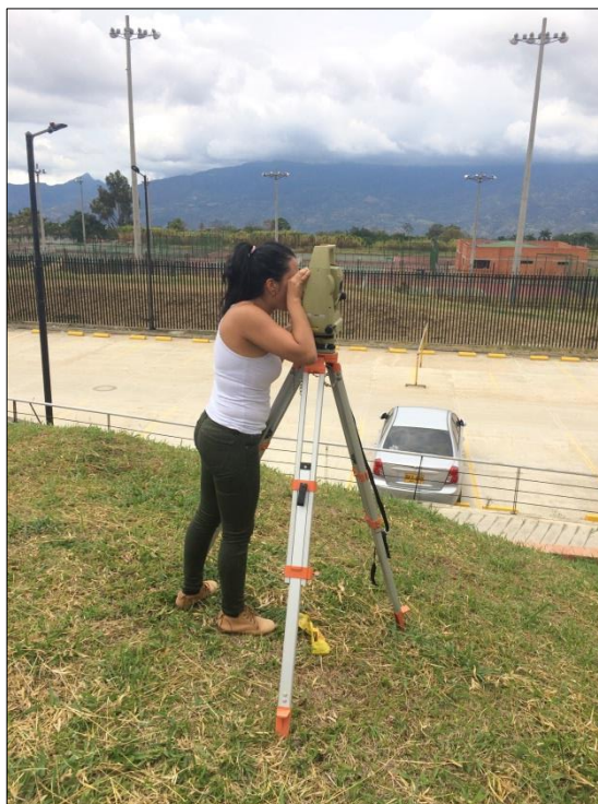
Fotografía 3 Toma de detalles zona de parqueaderos. Fuente: Propia
