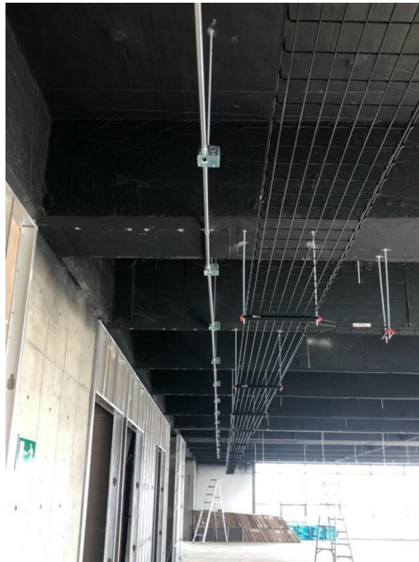
Figura 36. Instalación de tubería EMT para cableado estructurado
