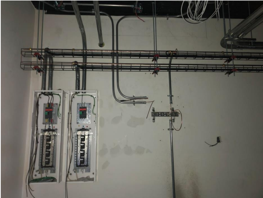
Figura 26. Tendido de Cable acometida potencia
