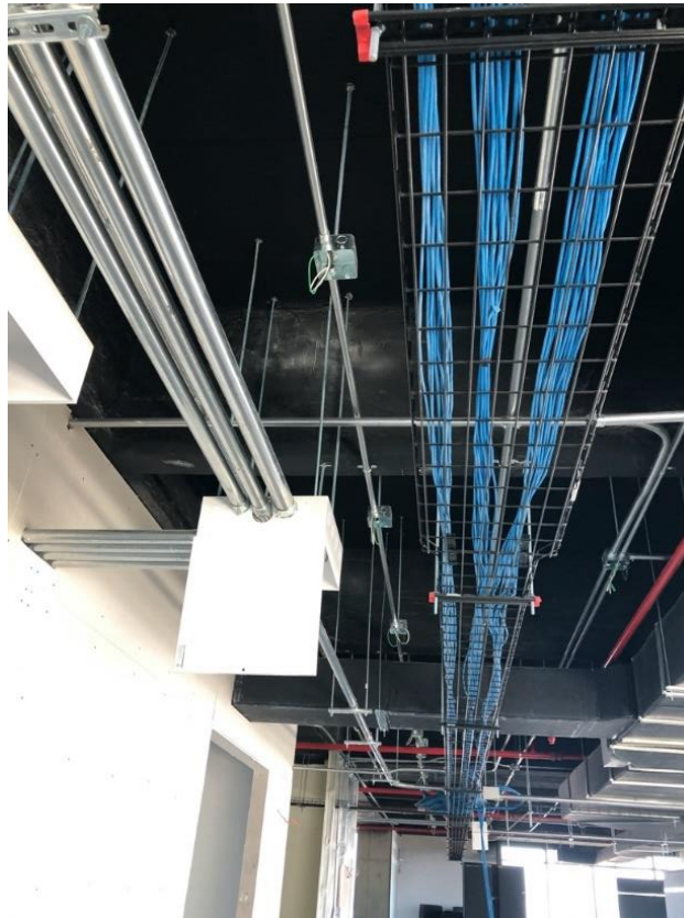
Figura 37. Tendido de cable por bandeja porta-cable
