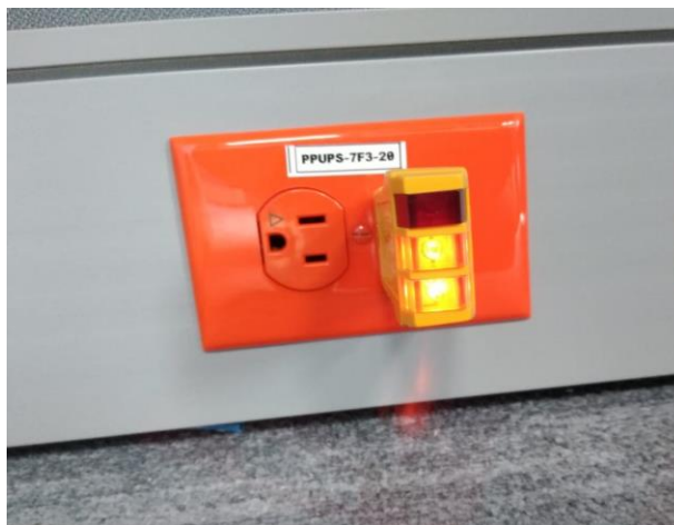
Figura 49.Prueba en toma reguladas
