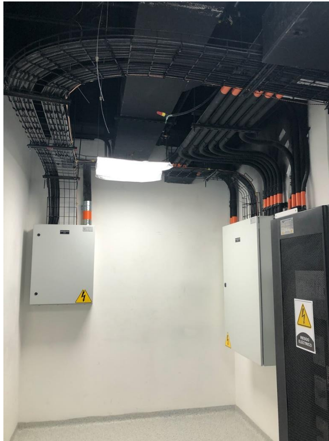
Figura 31. Peinado de cable por bandeja
