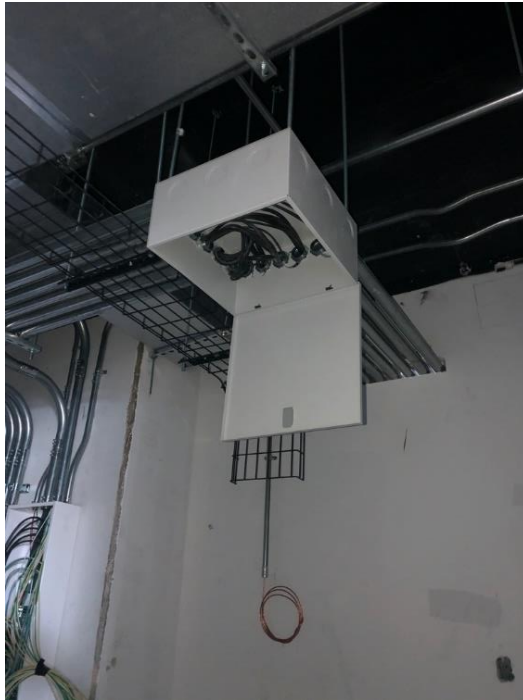
Figura 29. Tendido de cable de tubería por techo
