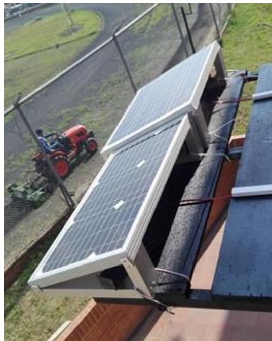
Figura 19 Instalación paneles fotovoltaicos monocristalino y policristalino Fuente: Propia
