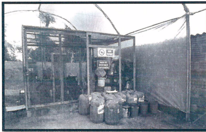
Imagen 8. Almacenamiento de Aceites Usados
