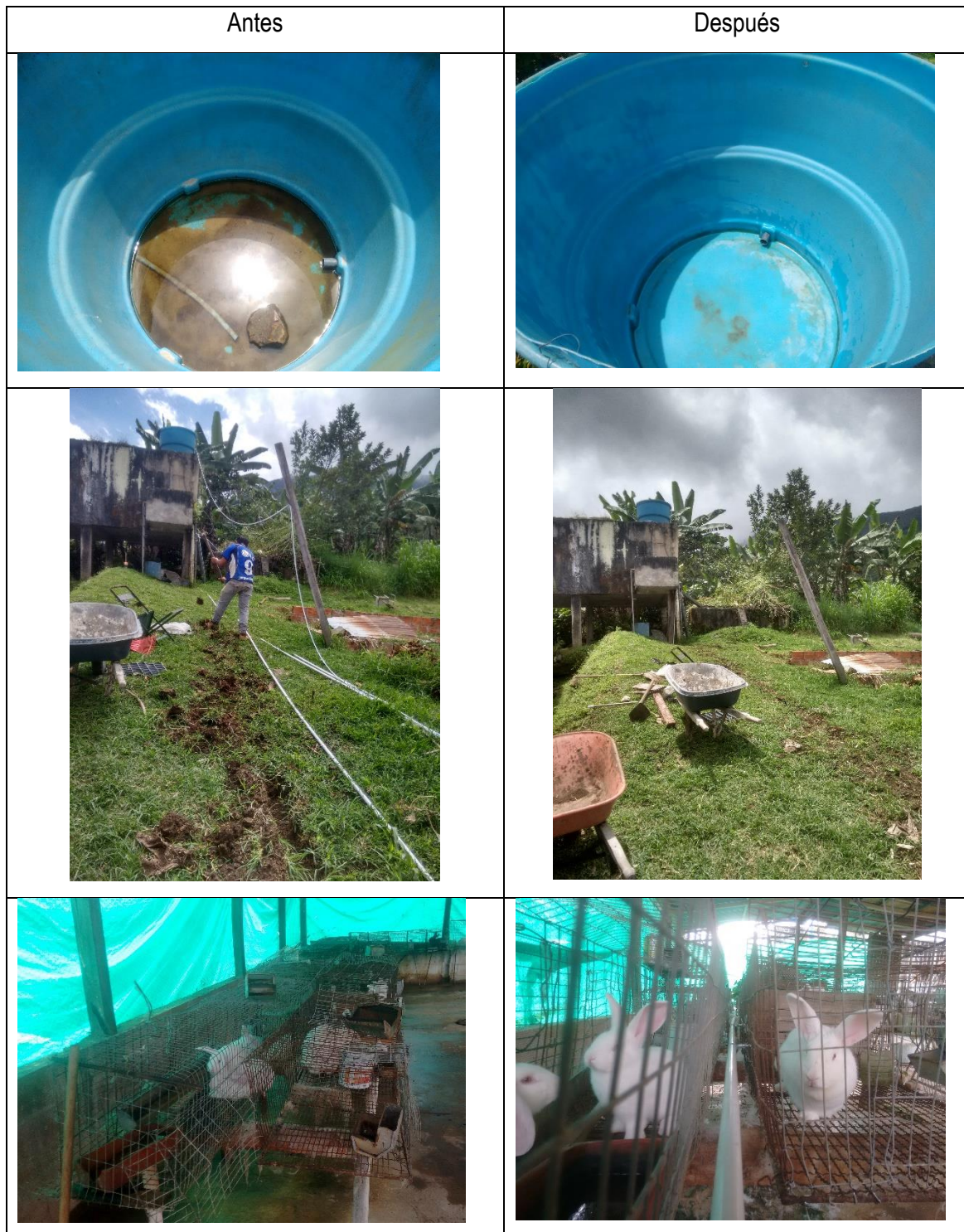
Figura 12. Instalación de tanque de almacenamiento, tubería, y bebederos automáticos.
