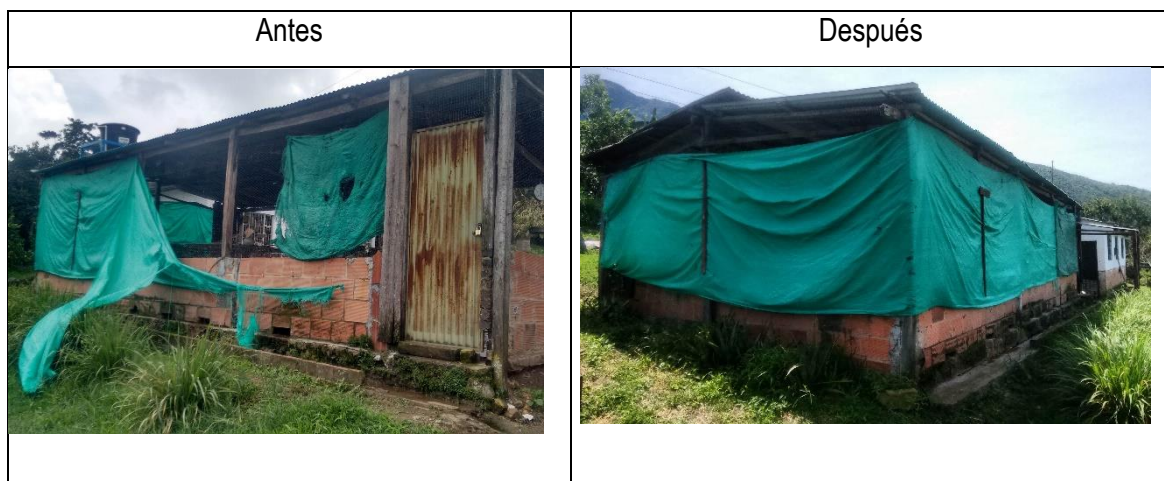
Figura 10. Adecuación de cortinas
