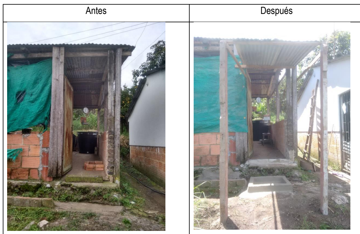
Figura 11. Instalación de pediluvios.
