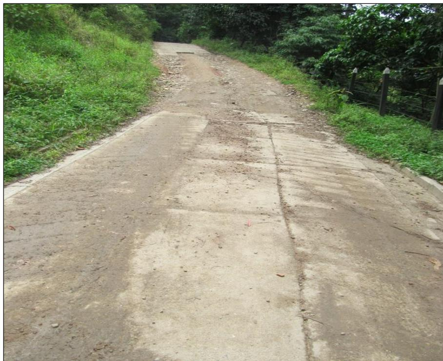
*Fotografía 9 Placa huella con deterioro en la estructura (Vereda Subia) Fuente: Autores*
