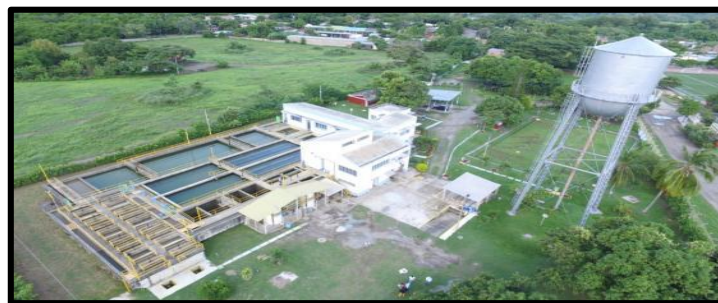
Figura 3. Estructura de la PTAP. EAAA del Espinal E.S.P (2018).
