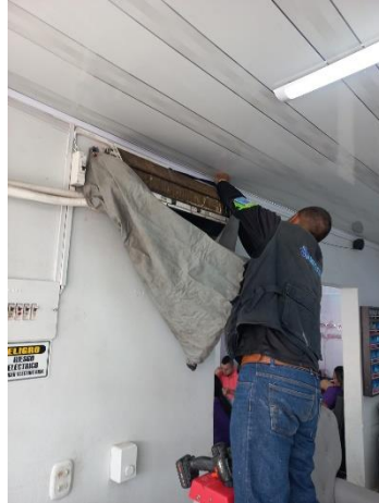
Ilustración 19 Instalación punto de lavado
