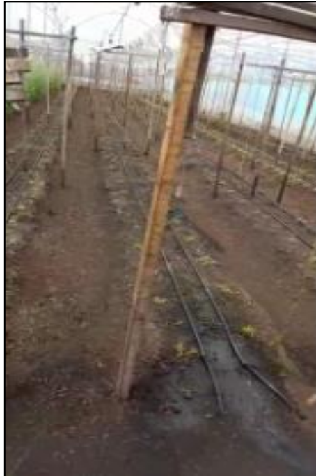
Imagen 1 Construcción de camas
