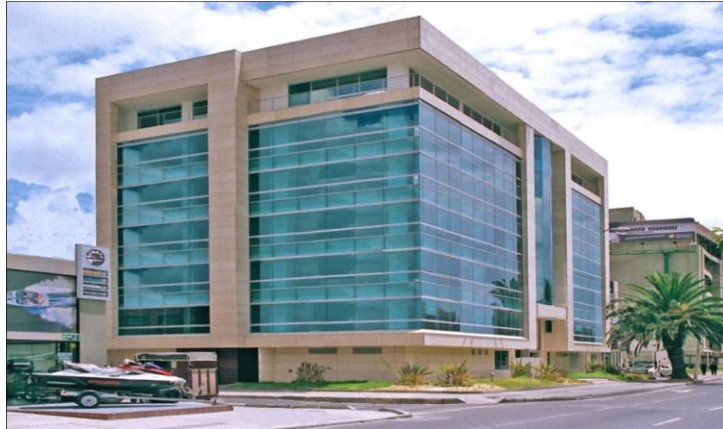
Ilustración 4 Edificio Uraki, Bogotá, Cundinamarca
