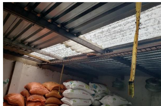
Ilustración 23. Cintas para control de moscas
