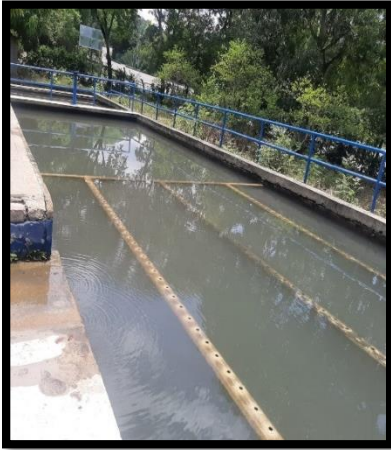
Sedimentador alta tasa
