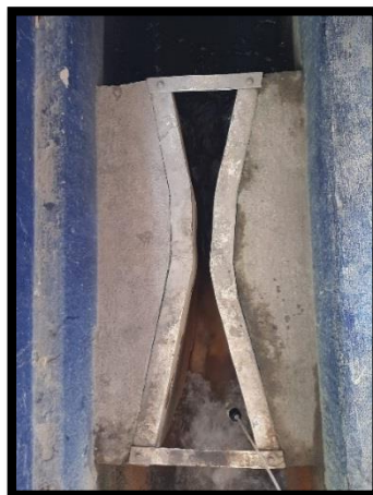
Ilustración 1 Canaleta Parshall
