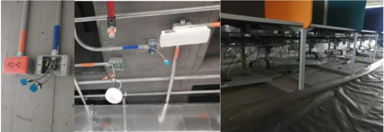
Figura 13. Punchado de puntos de televisión, Access point y puestos de trabajo
