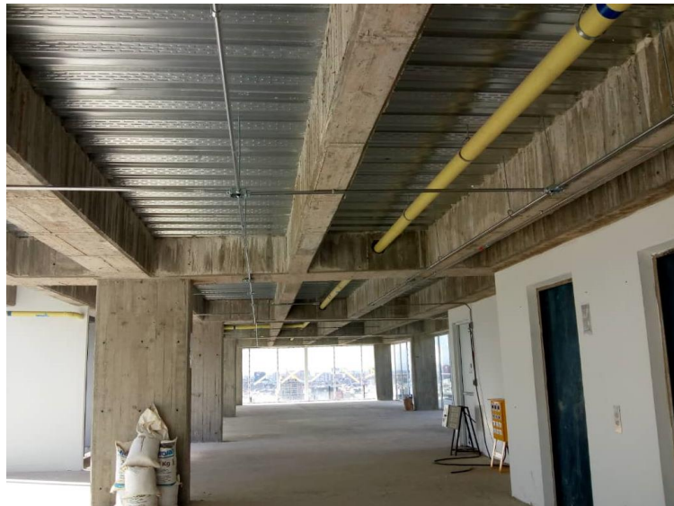
Figura 1. Entrega de pisos en obra negra para instalación de sistema de cableado estructurado
