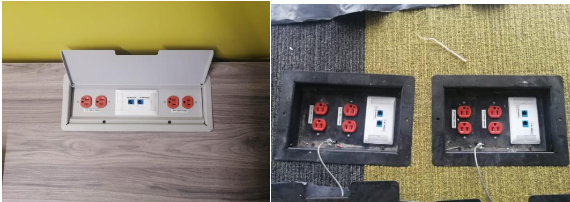
Figura 15. Módulos de conexión para mesas de salas de juntas y para piso
