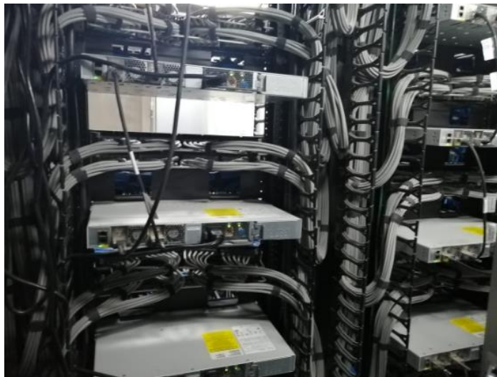
Figura 14. Conexión de puntos de datos al conmutador
