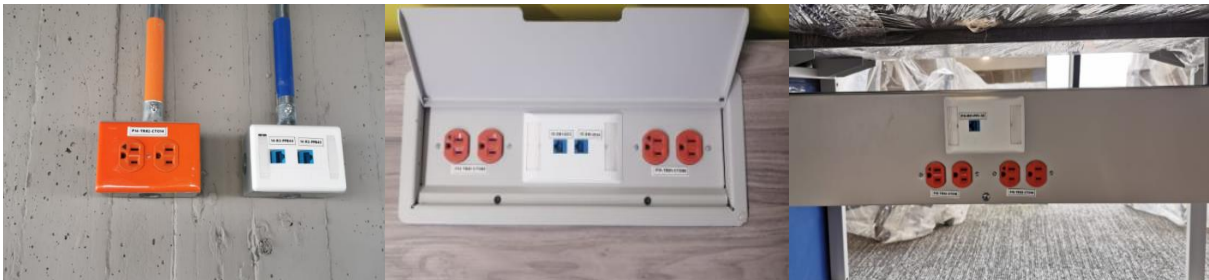
Figura 19. Marquilla de puntos de televisión, salas de juntas y puestos de trabajo
