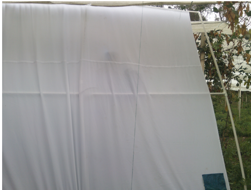
Figura 4.5: Imagen de la estructura. Fuente: Autor
