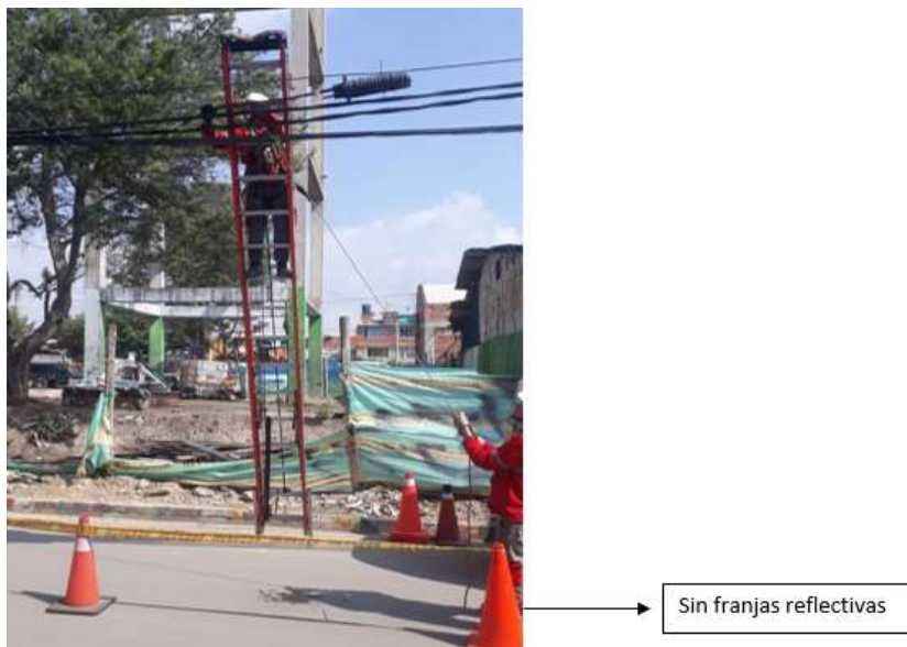
Figura 23 Trabajo en alturas.
