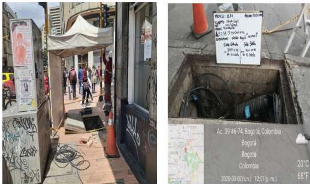
Figura 36 Señalización de cámaras Enel-Codensal.
