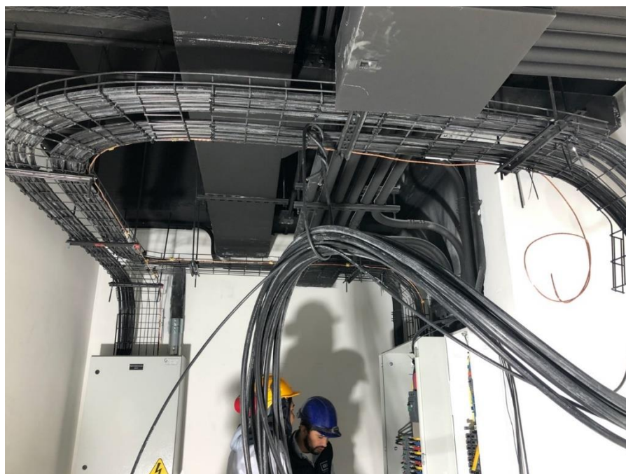
Figura 28. Tendido de cable en cuartos técnicos a UPS
