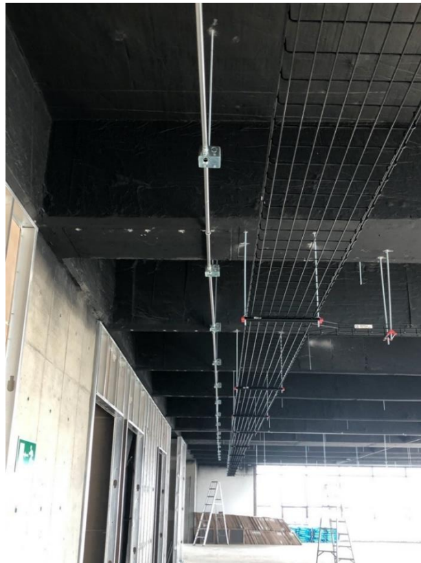
Figura 36. Instalación de tubería EMT para cableado estructurado
