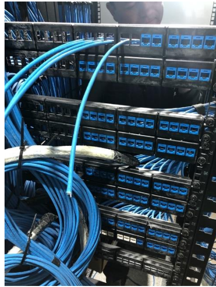
Figura 46. Instalación de paneles
