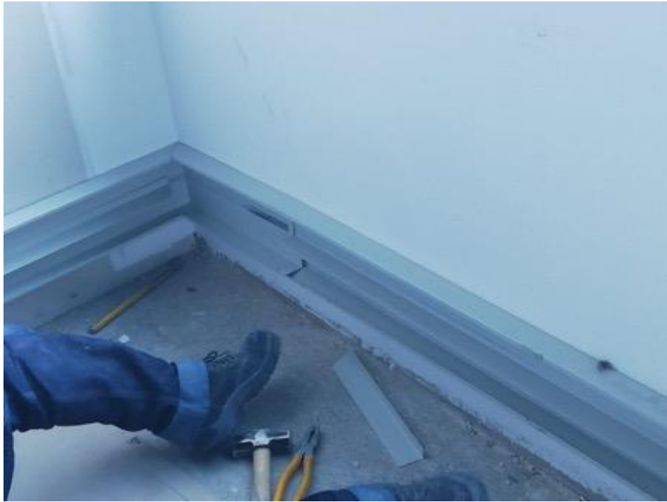
Figura 34. Instalación de canaletas por piso
