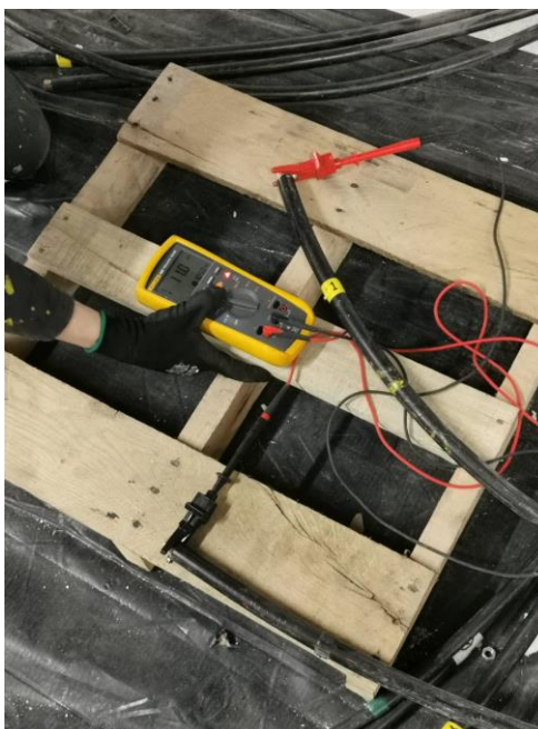
Figura 51. Prueba de conductores con megohmetro
