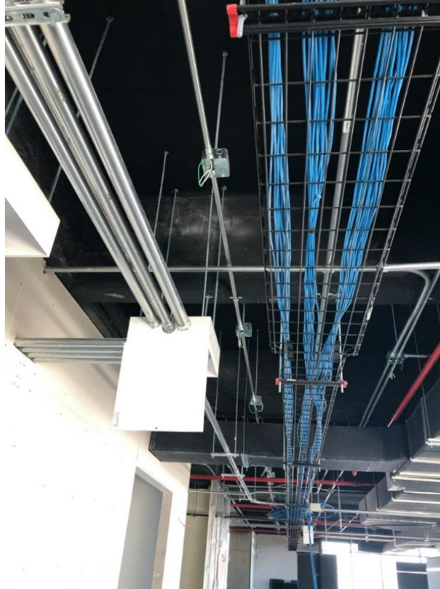
Figura 37. Tendido de cable por bandeja porta-cable
