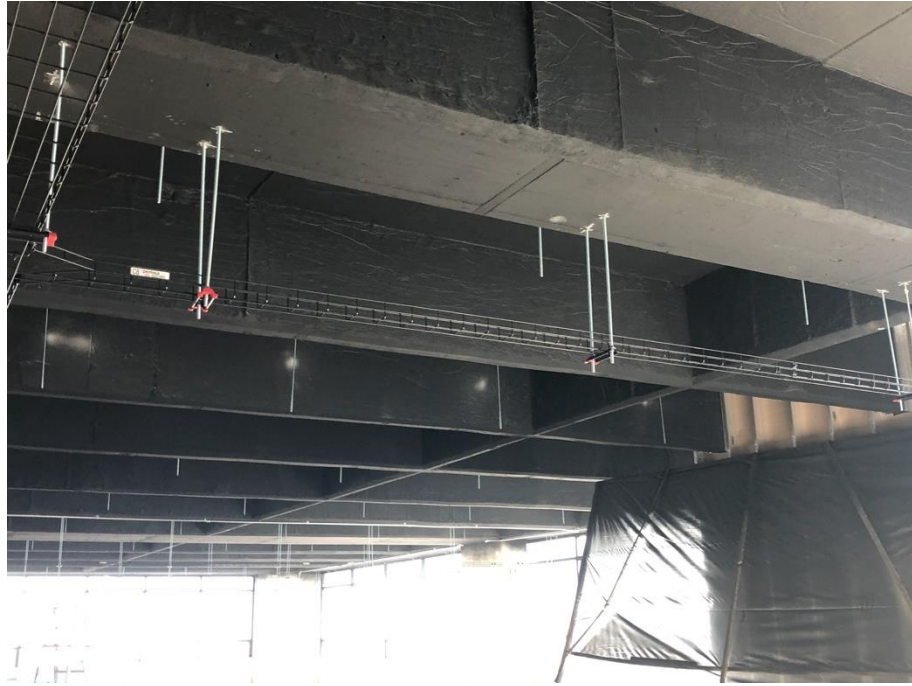
Figura 35. Instalación de bandeja porta-cable
