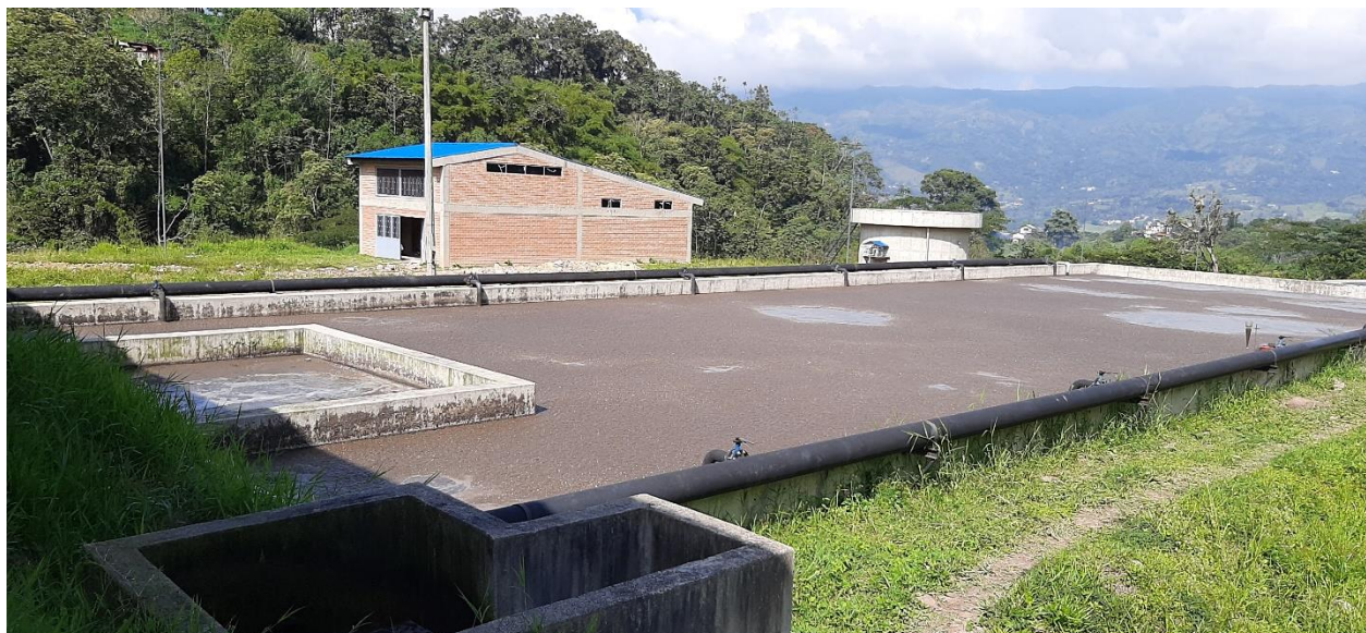
Ilustración 14. Instalaciones de la PTAR de Fusagasugá
