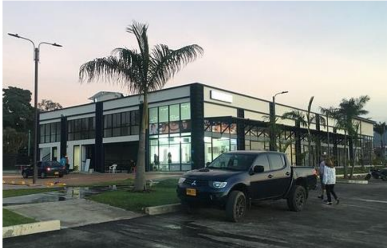
Figura 13. Centro comercial La Querencia
