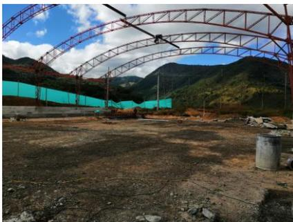
Parte del suelo de la obra, sin capa exterior de concreto, y se llevara a cabo la remoción de 20 cms de recebo en toda la parte donde se ubica la cancha.
