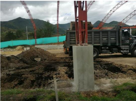
Luego de retirada la placa, se retiran 20 cms de recebo que es la capa siguiente a la placa de concreto.
