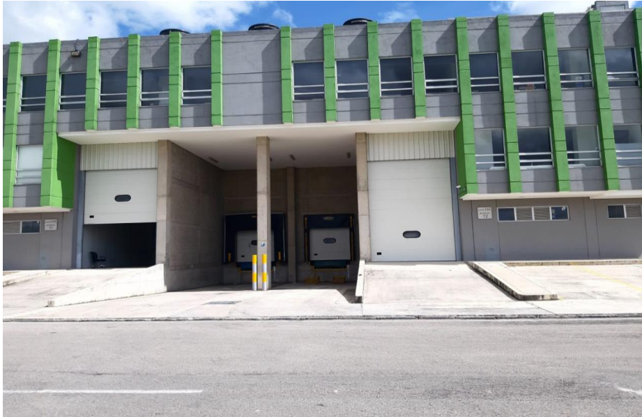
Anexo 1. Lugar de cargue y descargue de vehículos.
