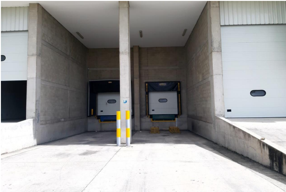
Anexo 2. Muelles de ubicación de vehículos para cargue y descargue.
