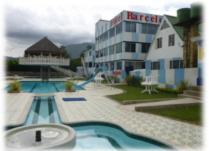
FIGURA 49 Piscinas Hotel Barcelona
