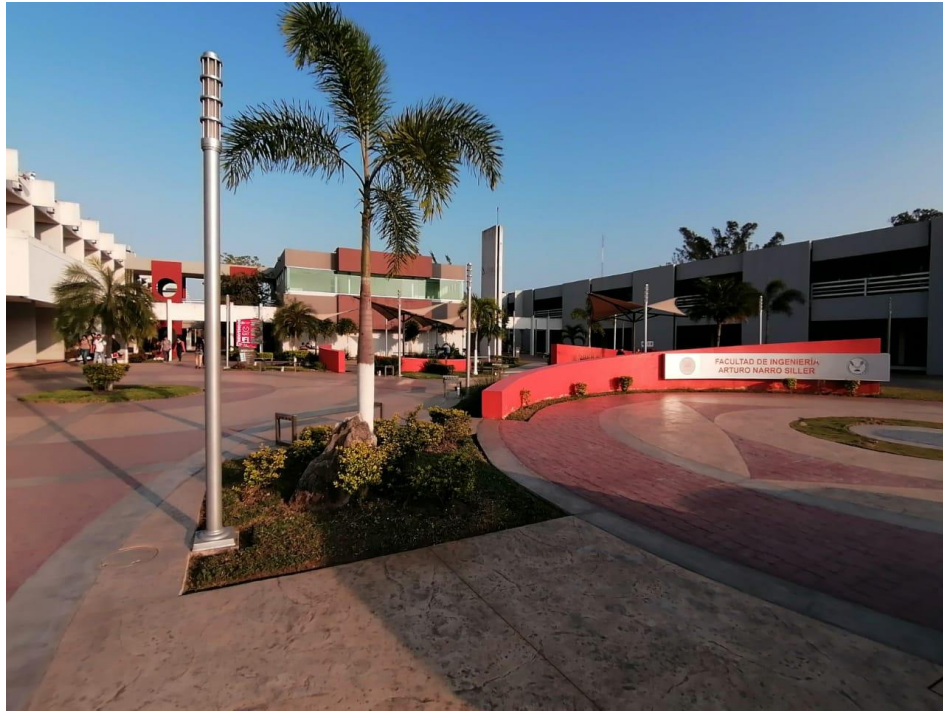
Figura 8 Facultad de Ingeniería "Arturo Narro Siller". Fuente: Elaboración Propia.
