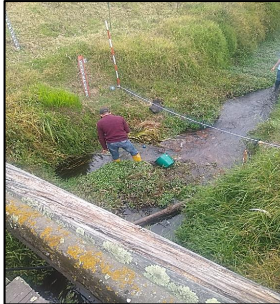
Figura 12: Levantamiento de secciones transversales y cotas, mediante nivelación y batimetría.
