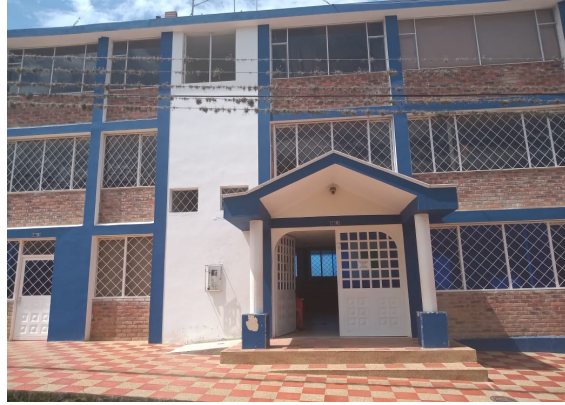
Ilustración 4 Fachada del Colegio Gimnasio Cora
