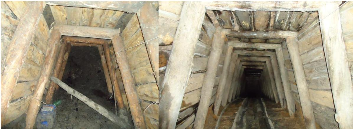
**Imagen 6: Socavón realizado por campesinos en Vereda Tibita el Carmen:** Los socavones se sostienen gracias a la madera o “puertas” como ellos las denominan, así a medida que se avanza en la apertura del túnel se van colocando estas puertas para sostener la tierra, prevenir accidentes y avanzar. Autoría propia.
