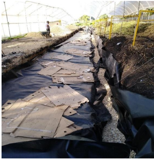
Ilustración 21 Terminación de geo membrana para área de compost
