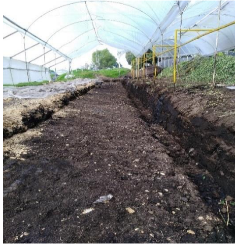
Ilustración 3 Realización de filtro Remoción de tierra
