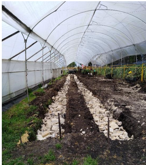
Ilustración 15 Área de COMPOST proceso
