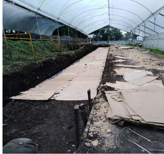
Ilustración 4 Proceso de filtro en las pilas Capa de cartón sobre el terreno para la protección de la geo membrana
