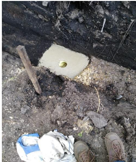
Ilustración 5 instalación de desagüe para el filtro y el tanque de lixiviados
