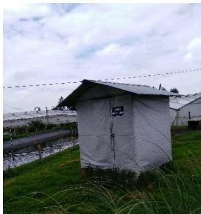
Ilustración 38 centro de acopio de residuos de aceites usados
