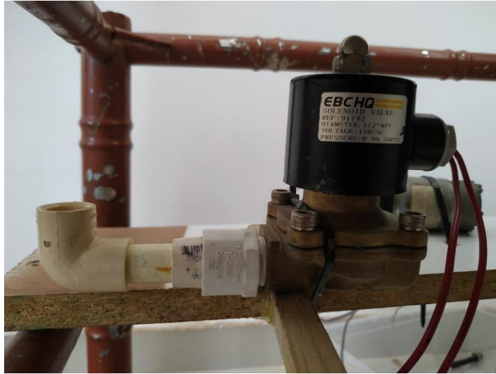
Figura 72. Válvula implementada en el sistema
