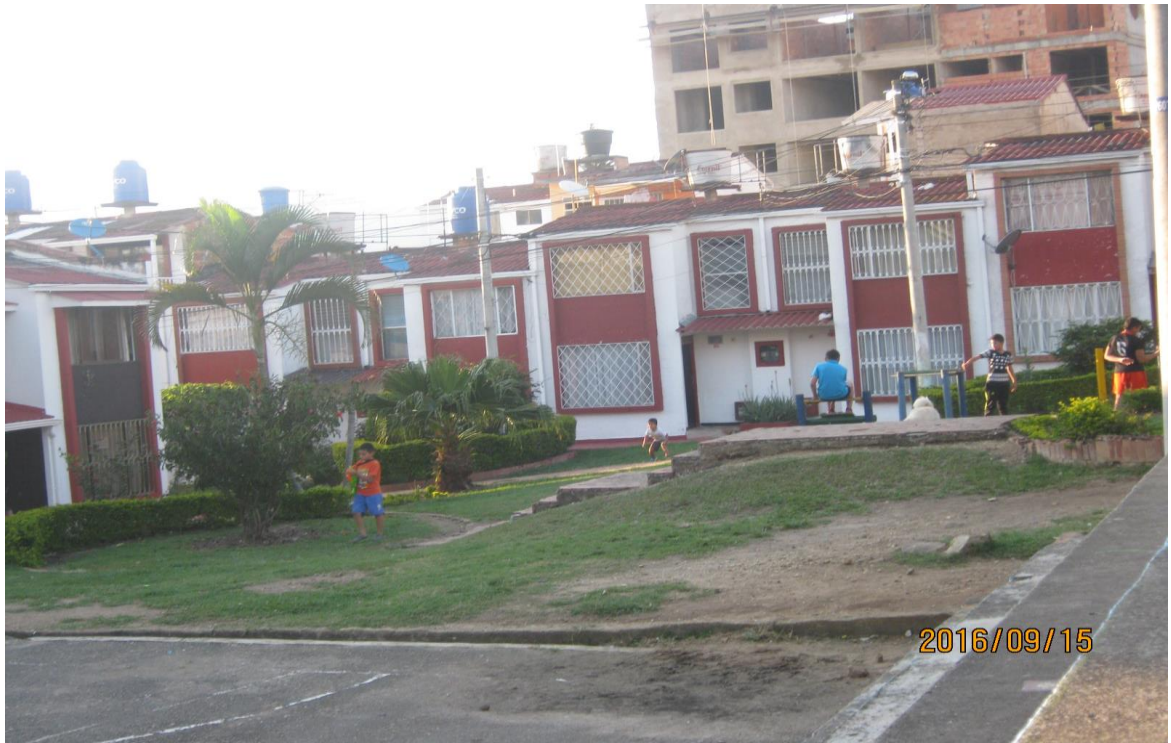
Figura 4. Estructura de viviendas Ciudadela Comfenalco
